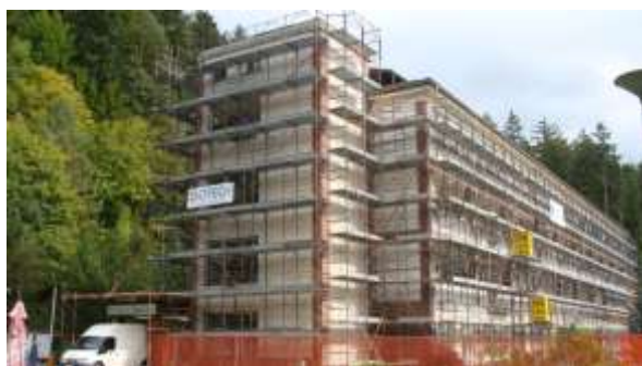
Slika (Janez Sevcnikar): Priprava del – pogled iz sprednje strani BT
